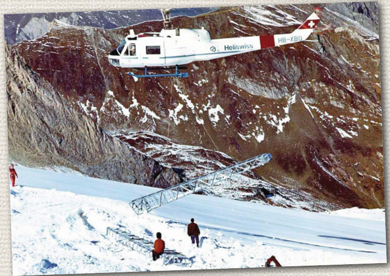
Bei der Errichtung des Einsesselliftes Gefrorene Wand (1971) kommt ein Hubschrauber zum Einsatz
